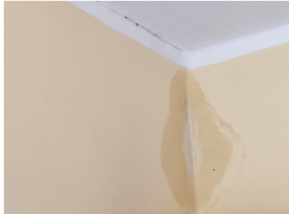
Requiere mantenimiento correctivo de acabado de muros por filtración de agua.
