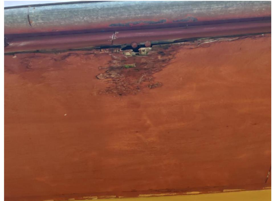
Requiere mantenimiento correctivo de cielo raso de madera
