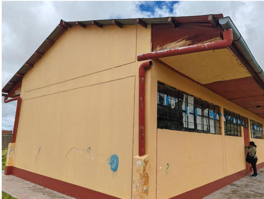
Requiere mantenimiento correctivo de canaleta y montante
