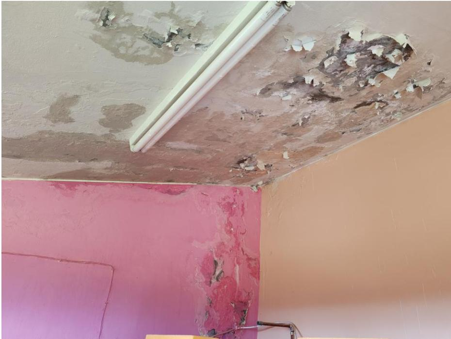
Requiere mantenimiento correctivo de losa aligerada, incluye impermeabilización
