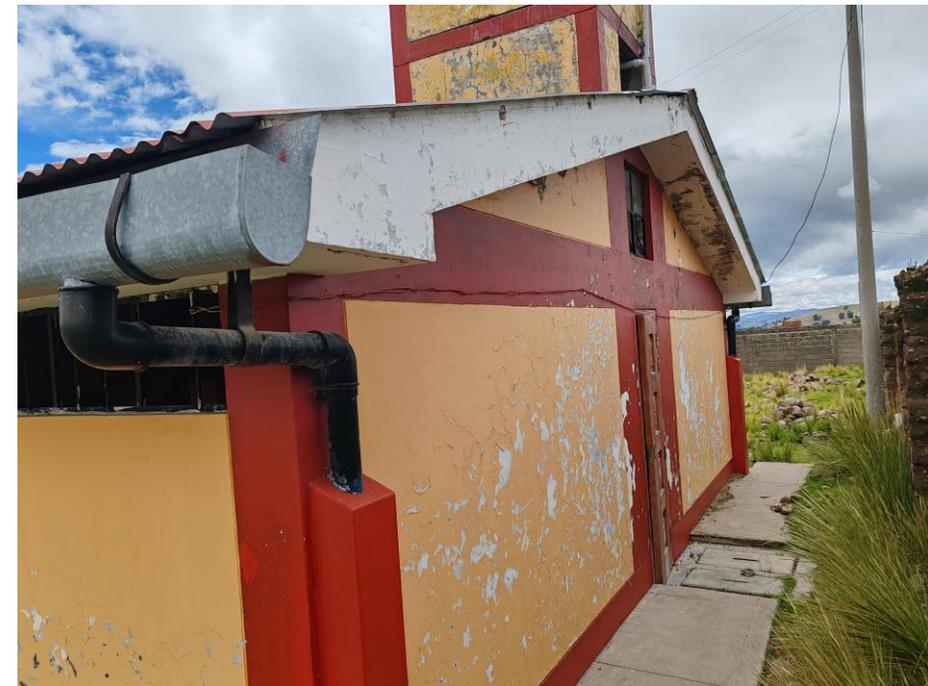
Requiere mantenimiento correctivo de tarrajeo de cemento, incluye impermeabilización
