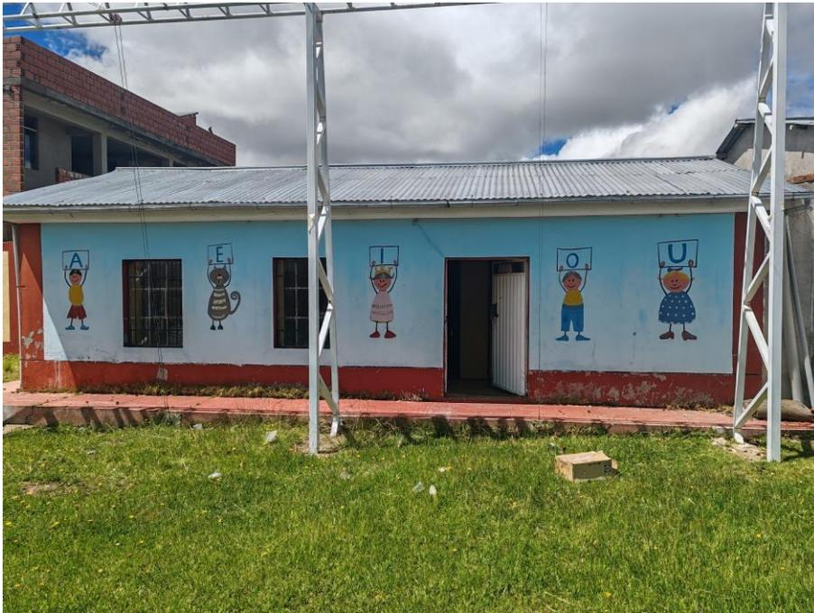
Requiere instalación de montante y canaleta para evacuación de aguas pluviales
