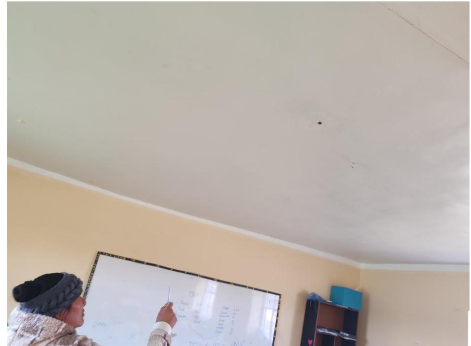
Requiere mantenimiento correctivo de cobertura de calamina y cielo raso
