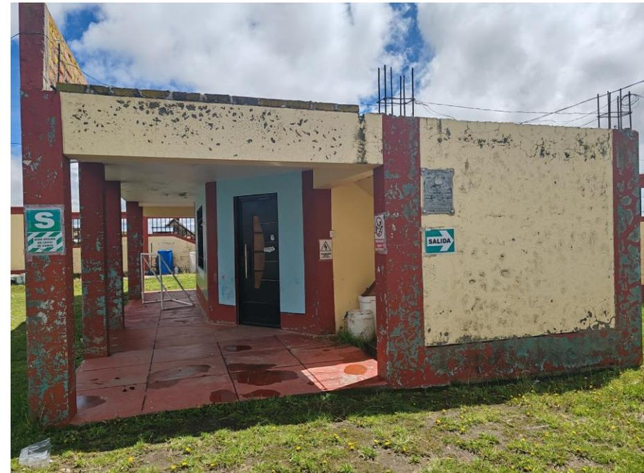
Requiere mantenimiento correctivo de tarrajeo de cemento, incluye impermeabilizante
