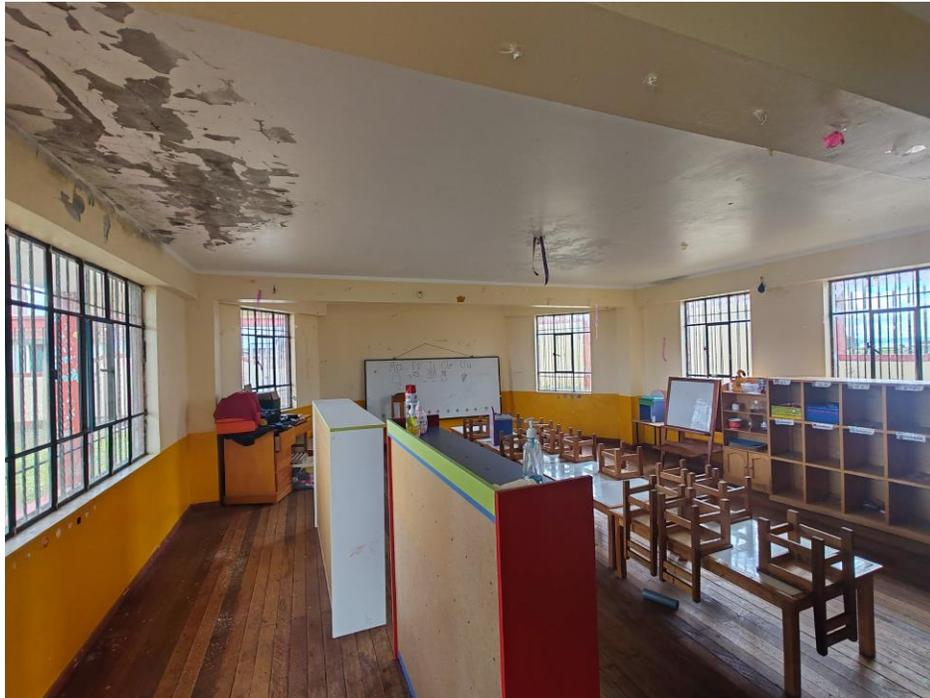
Requiere mantenimiento correctivo de acabado de losa aligerada
