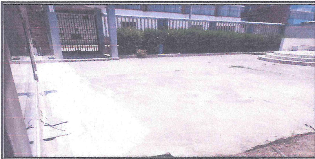
SE APRECIA EN LA FOTOGRAFIA CON EL PATIO
