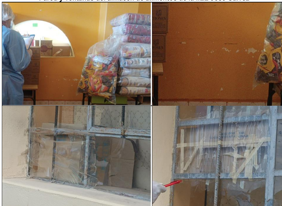
Pared y ventanas del almacén de alimentos de la IIEE José Gálvez
