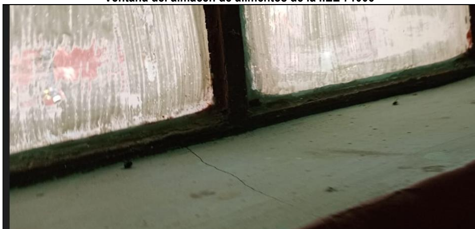
Imagen n.º 16 Ventana del almacén de alimentos de la IIEE 71006
