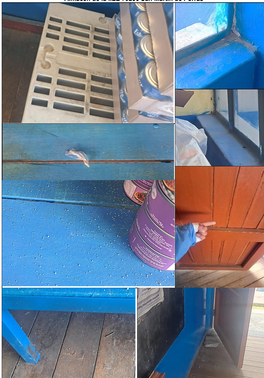
Imagen n.º 23 Almacén de la IIEE 70256 San Martín de Porras
