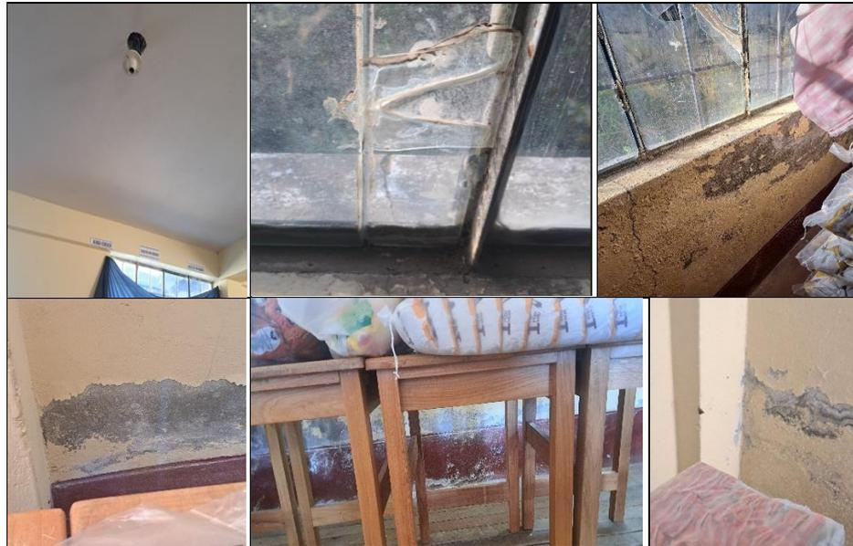
Falta de mantenimiento en el almacén; el techo presenta un socket eléctrico desprendido; la ventana tiene vidrios quebrados y las paredes presentan deterioros por la humedad y filtración de agua; así como, desprendimiento de pintura (**Imagen n.º 2**).
