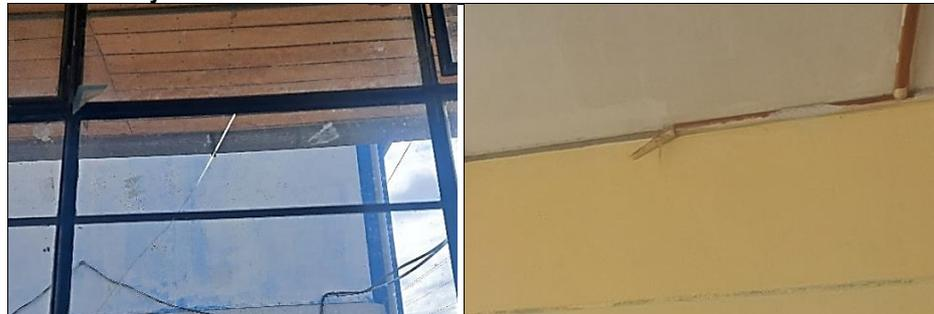
Falta de mantenimiento en el almacén; las ventanas tienen vidrios quebrados y el techo se viene deteriorando (astillado).
