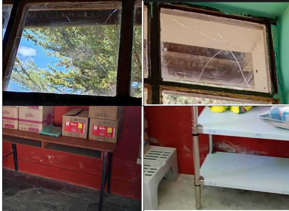
Falta de mantenimiento en el almacén; las ventanas tienen vidrios quebrados y las paredes presentan deterioros por la humedad y filtración de agua; así como, desprendimiento de pintura.
