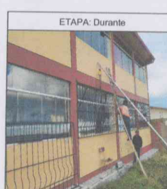
Proceso de instalación de las rejas de seguridad
