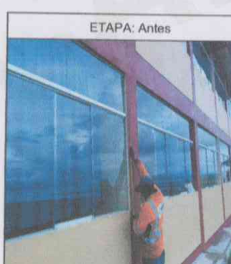
Ventanas antes de la instalación de las rejas de seguridad
