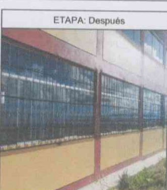
Instalación de rejas de seguridad finalizado
