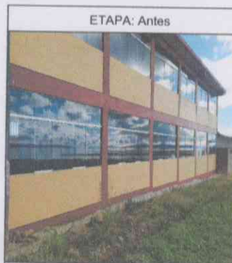
Ventanas antes de la instalación de las rejas de seguridad
